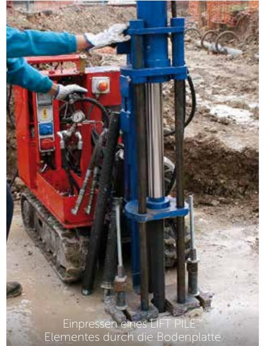
Der Druckmikropfahl hat eine zylindrische Form, zusammengesetzt aus mehreren Stahlrohren, die durch Gewinde miteinander verbunden sind. Dieser Druckmikropfahl wird im Fundament mit Druck durch einen Hydraulikzylinder verankert, um das Gebäude zu heben und zu festigen.
